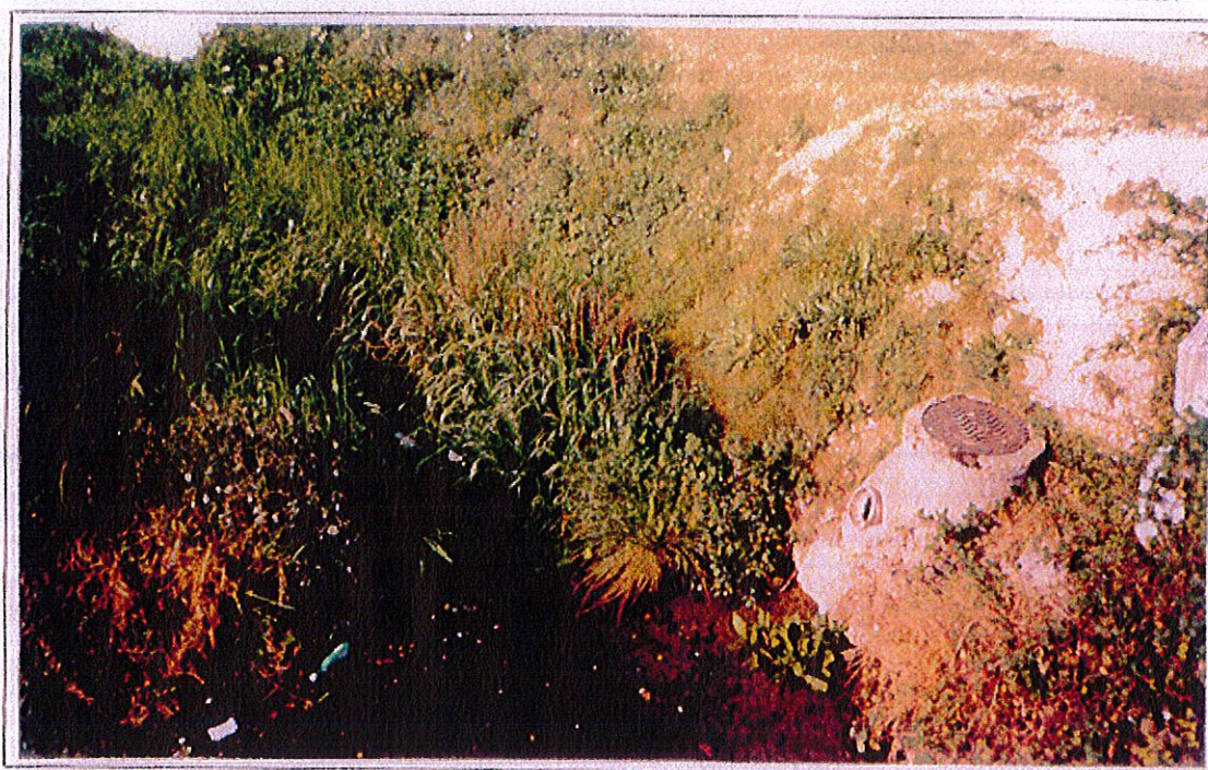
VUE DE L'EXUTOIRE DU TROP-PLEIN
